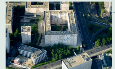
18 Résidence Boieldieu , immeubles de logements, témoignage du premier plan d'urbanisme, Gilbert et Rabaud, 1966
